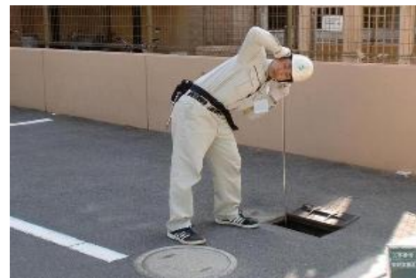
《漏水調査 (戸別・弁栓音聴)》
