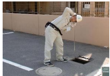
《漏水調査 (戸別・弁栓音聴)》
