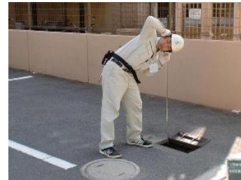
《漏水調査 (戸別・弁栓音聴)》
