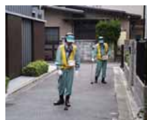
漏水調査 (路面音聴)
