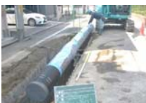
▲管路の更新工事
