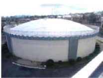
▲更新した坪井配水池
