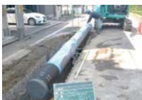
▲管路の更新工事
