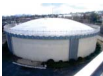
▲更新した坪井配水池
