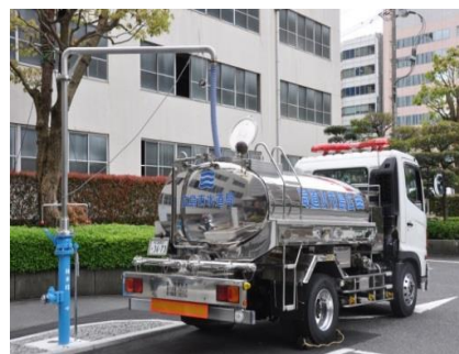
【応急給水対策の推進 (緊急時給水車専用水栓)】
